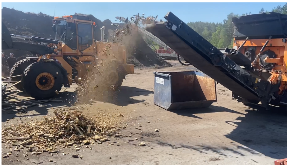
Figur 2. Flisning av trävirke (Foto: Roslagsvatten AB)
