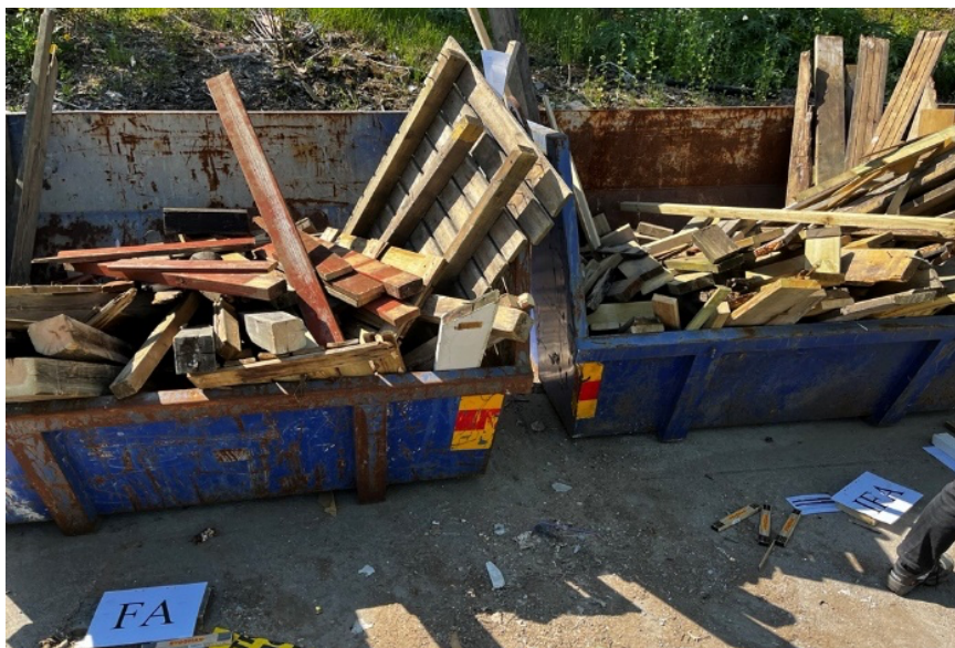
Figur 1. Pågående försök med sortering av behandlat virke i FA och IFA fraktioner (Foto: Siri Ranung, Ramboll).
